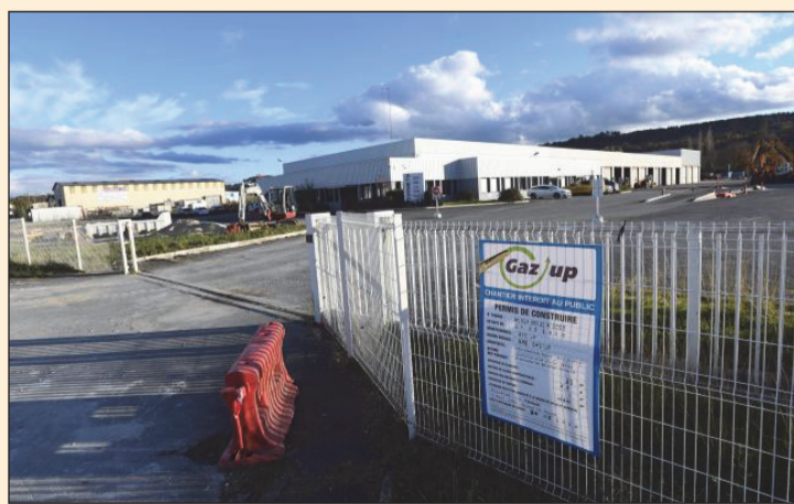
Actuellement en chantier, la station gaz devrait ouvrir ses portes dans le courant du mois de mars. PHOTO RÉMI PHILIPPON
